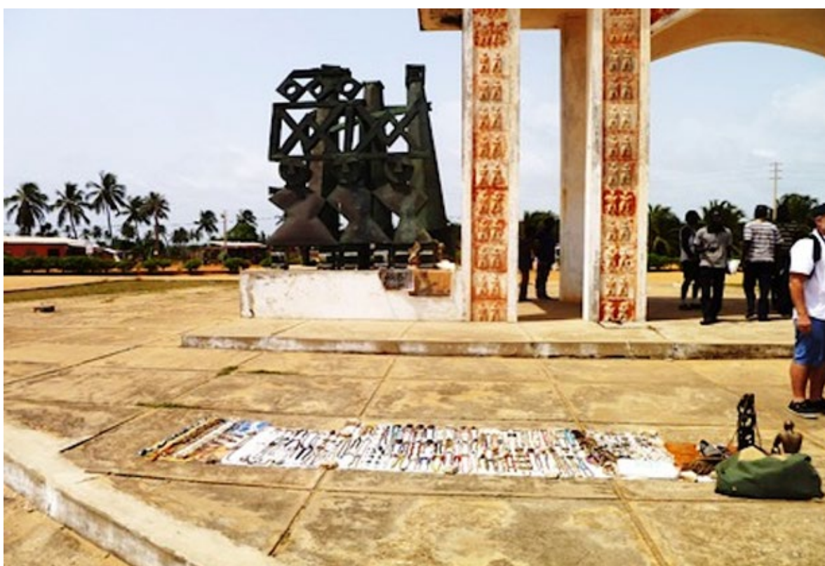
Ill. 4 : Récupération sociale du monument : Vente à la sauvette au pied de la Porte du non-retour. Photo Gbègnidaho Achille Zohoun
