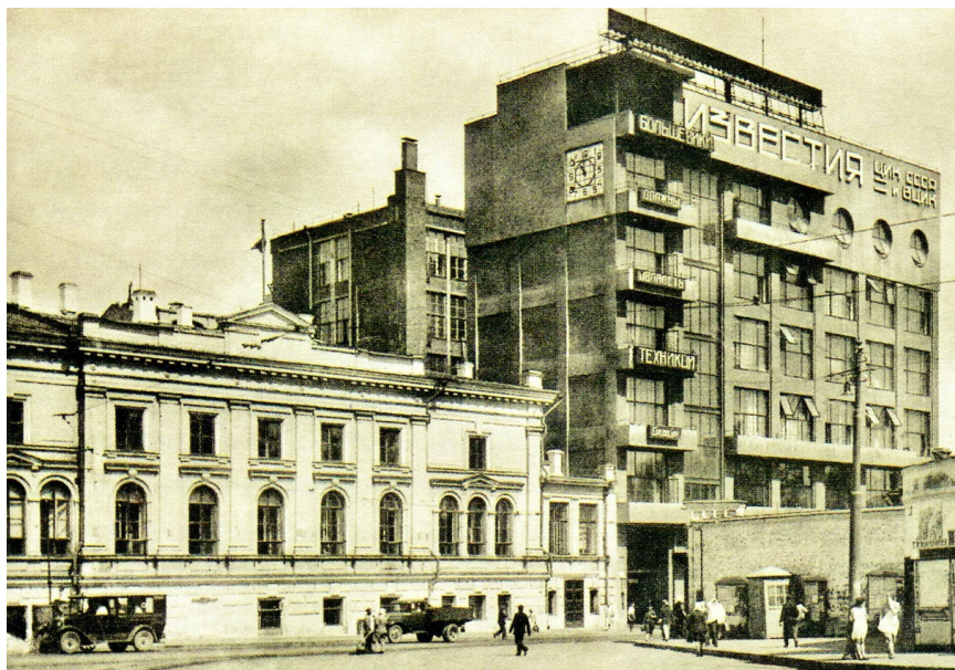
Figura 4. À esquerda, o edifício de três andares em Strastnaia (agora Pushkinskaia) Ploshchad', Moscou, que abrigou a KUTV na década de 1930. À direita está o prédio alto do jornal Izvestiia . Hoje em dia, o edifício da KUTV não existe mais
