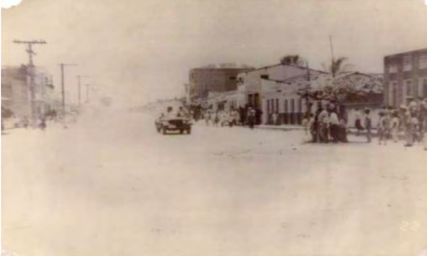
Figura 2 RUA PRINCIPAL DO POVOADO KM 64 - EUNÁPOLIS - EM 1968
