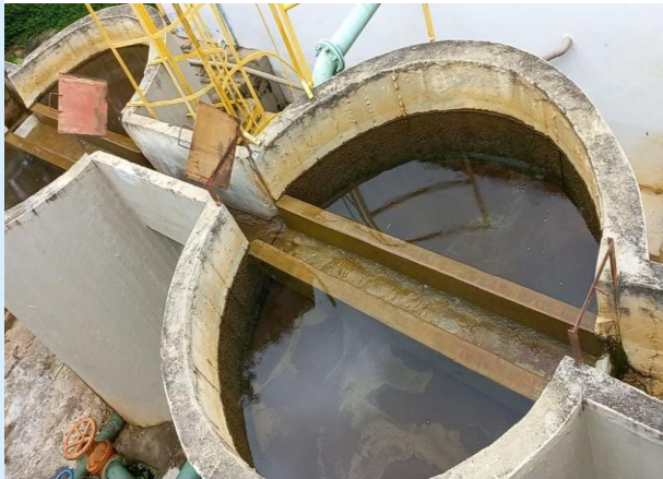
Figura 2 - a) Decantador da ETA onde é produzido o lodo / b) Processo de lavagem do filtro com produção da água de lavagem que é descartada no rio, juntamente com o lodo dos decantadores
