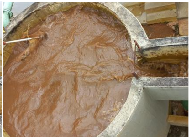
Figura 2 - a) Decantador da ETA onde é produzido o lodo / b) Processo de lavagem do filtro com produção da água de lavagem que é descartada no rio, juntamente com o lodo dos decantadores
