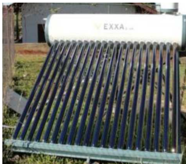
Figura 3 – Coletor solar com tubos à vácuo
