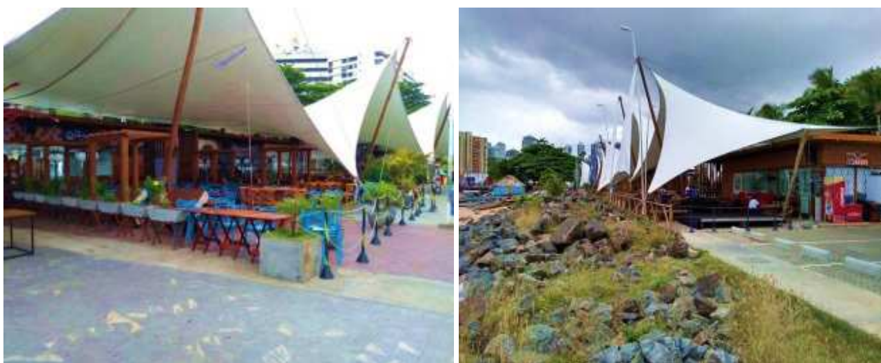
Figura 7 – Coberturas dos bares e restaurantes da Vila Caramuru
