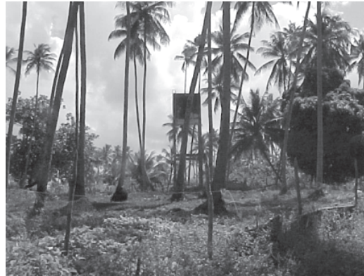
Foto 12. Caixa d'água situada no local das ruínas da Casa de Câmara e Cadeia.
