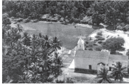
Foto 4. Vista do povoado de Vila Velha, com a Igreja de N. Sra. da Conceição em primeiro plano. Fonte: FUNDARPE, 1985.
