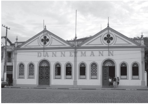
Figura 29: Vista geral do Centro Cultural Dannemann em São Félix.
