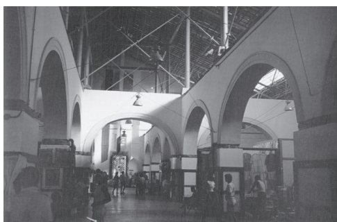
Figura 26: Vista do interior do Mercado Modelo, pavimento superior.
