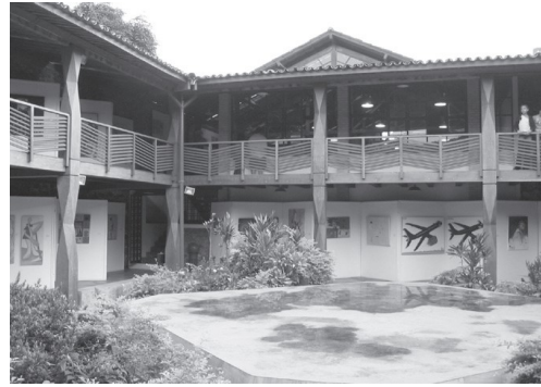
Figura 30: Vista interna do pátio do Centro Cultural Dannemann em São Félix.
