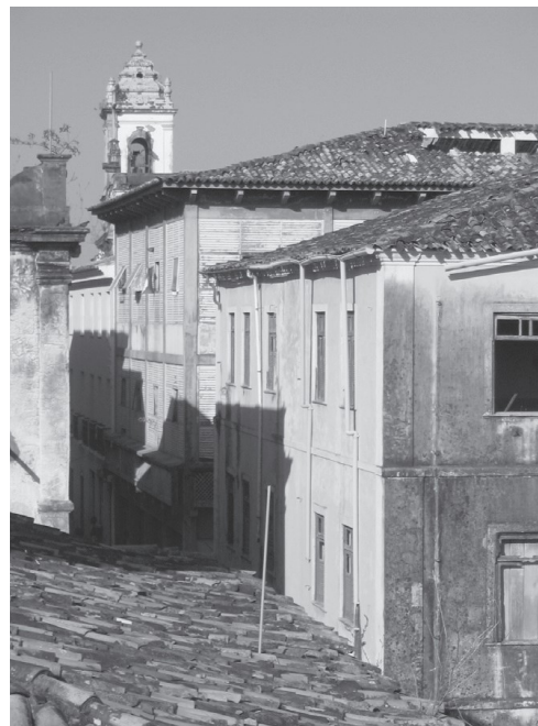
Figura 23: Vista geral do Edifício Ipê a partir do Paço do Saldanha.
