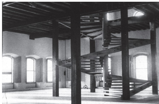
Figura 14: Vista da escada do Solar do Unhão. Fonte: Ferraz, 1996.
