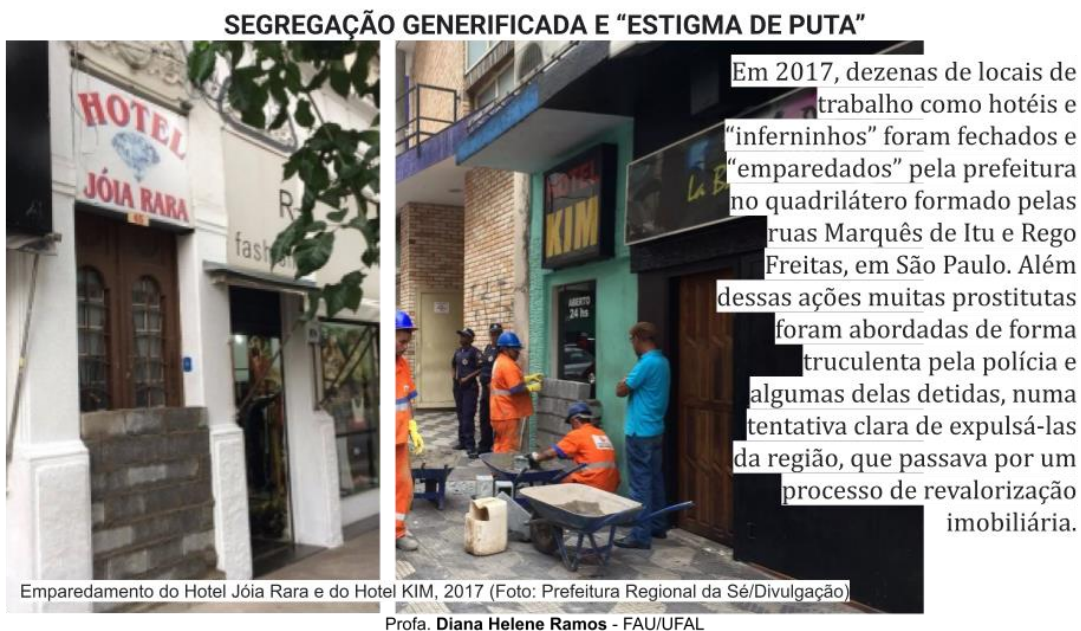
Figura 5. Emparedamento realizado pela Prefeitura de São Paulo. Fonte: Ramos (2015).
