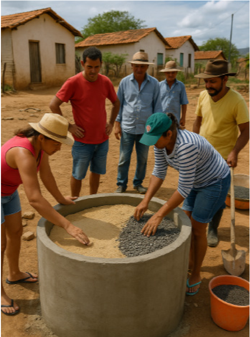
Figura 2 – Construção comunitária do filtro na comunidade de Pilar
