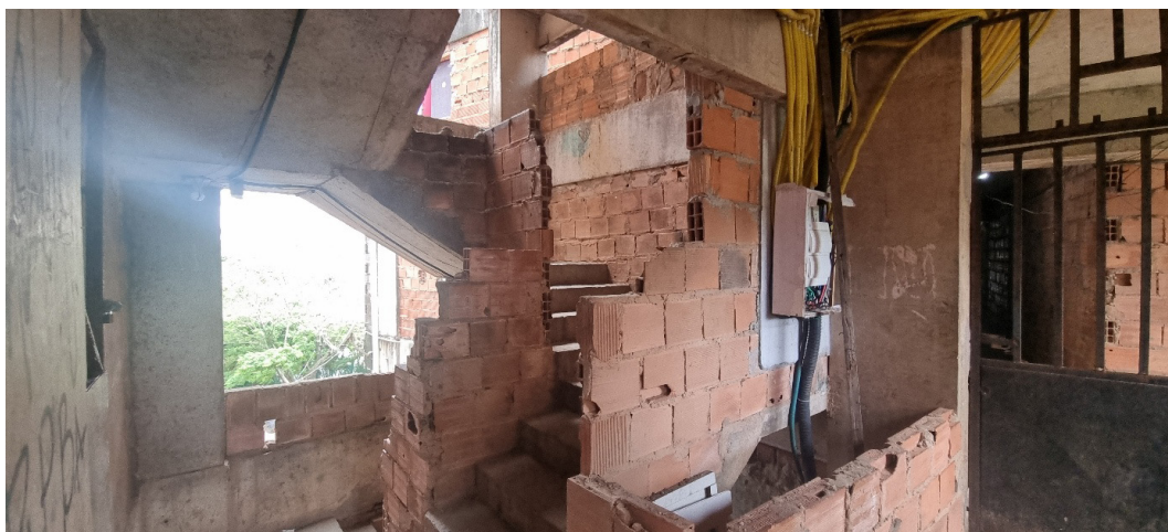
Foto 12 – Escada que dá acesso ao hall do andar e detalhes do hall do andar, é possível ver um portão de ferro que dá acesso ao corredor
