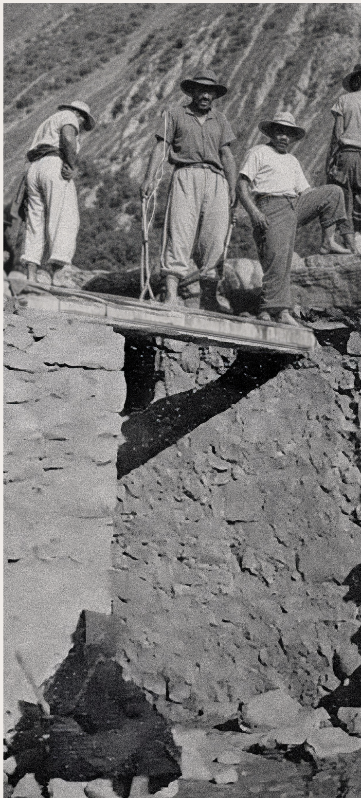
Figuras 9 e 10. Processos de autoconstrução de moradias através de processos de ação comunitária.
