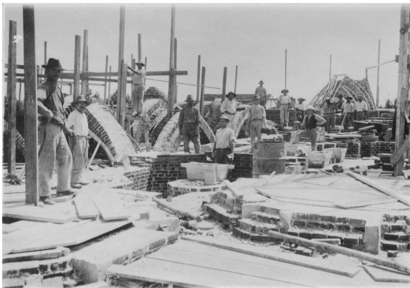
Imagem 3: Pedreiros na Obra da Igreja de São Sebastião Mártir de Venâncio Aires na década de 1920.
